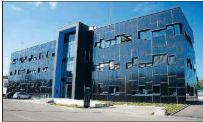
Die Nachhaltigkeitsorientierung zeigt sich bereits auf den ersten Blick – die Fotovoltaikfassade ist nicht nur schick, sondern deckt auch rund 60 Prozent des Energiebedarfs im Unternehmen. Foto: Mader GmbH & Co. KG
